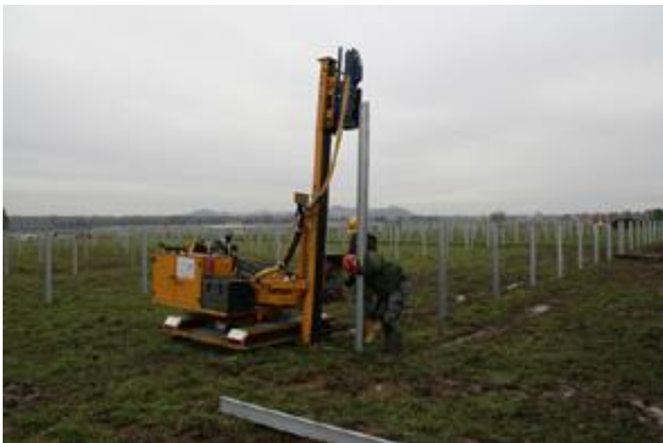
Zdjęcie 6 Montaż profili na potrzeby realizacji farmy fotowoltaicznej.
