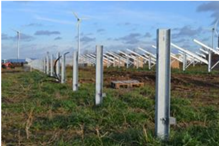
Zdjęcie 5 Profile metalowe: podstawowy element konstrukcji.
