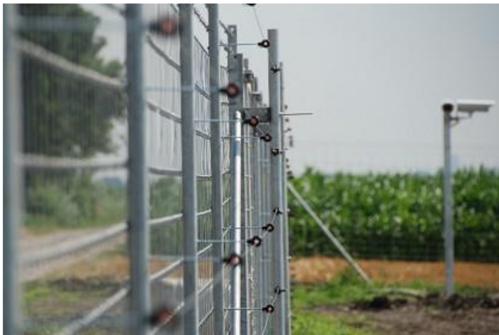
Zdjęcie 1 Przykładowe ogrodzenie farmy fotowoltaicznej
