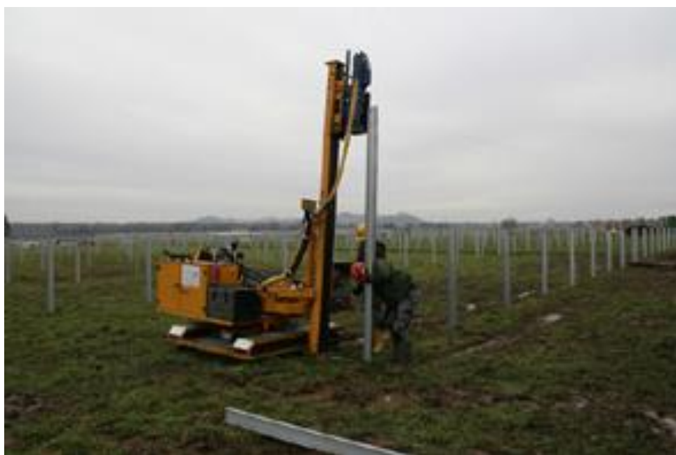
Zdjęcie 3 Montaż profili na potrzeby realizacji farmy fotowoltaicznej.
