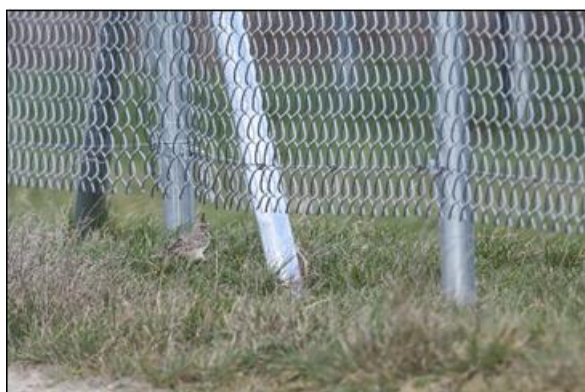
Zdjęcie 14 Dzierlatka swobodnie przechodząca pod ogrodzeniem farmy fotowoltaicznej w Brzostowie
