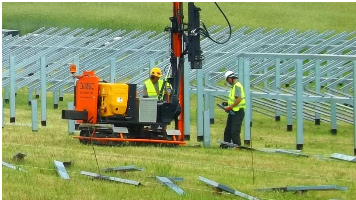
Rysunek 16 Katar samojezdny do wbijania słupów pod konstrukcje fotowoltaiczne
